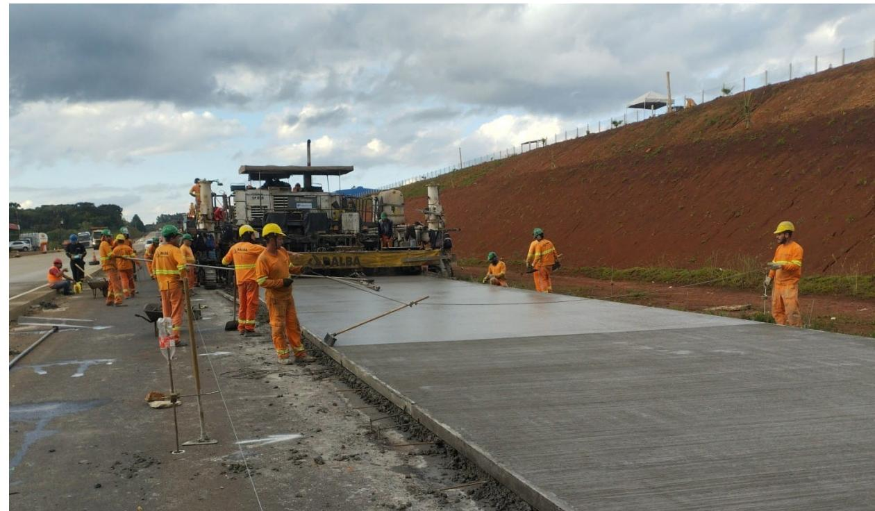
concreto. Este último está em andamento tanto na pista nova quanto na restauração da pista existente, aproveitando o asfalto melhorado como uma base para as novas placas de concreto, técnica chamada de "whitetopping".
