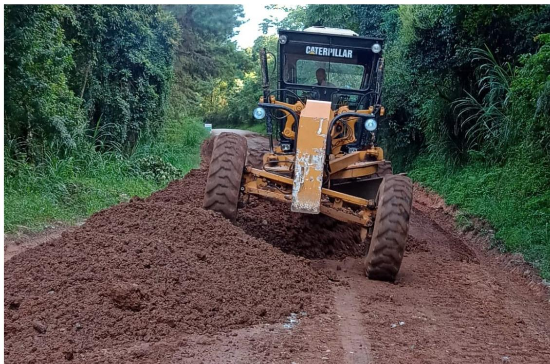
regularização por patolamento; regularização, conformação e compactação de leito e escarificação, conformação e compactação de subleito; preenchimento de segmento com rebaixo utilizando rachão; e reaterro e apiloamento. Também serão realizados serviços para melhorar a drenagem de águas nos trechos, como escavação de vala lateral rasa, de bueiros e
