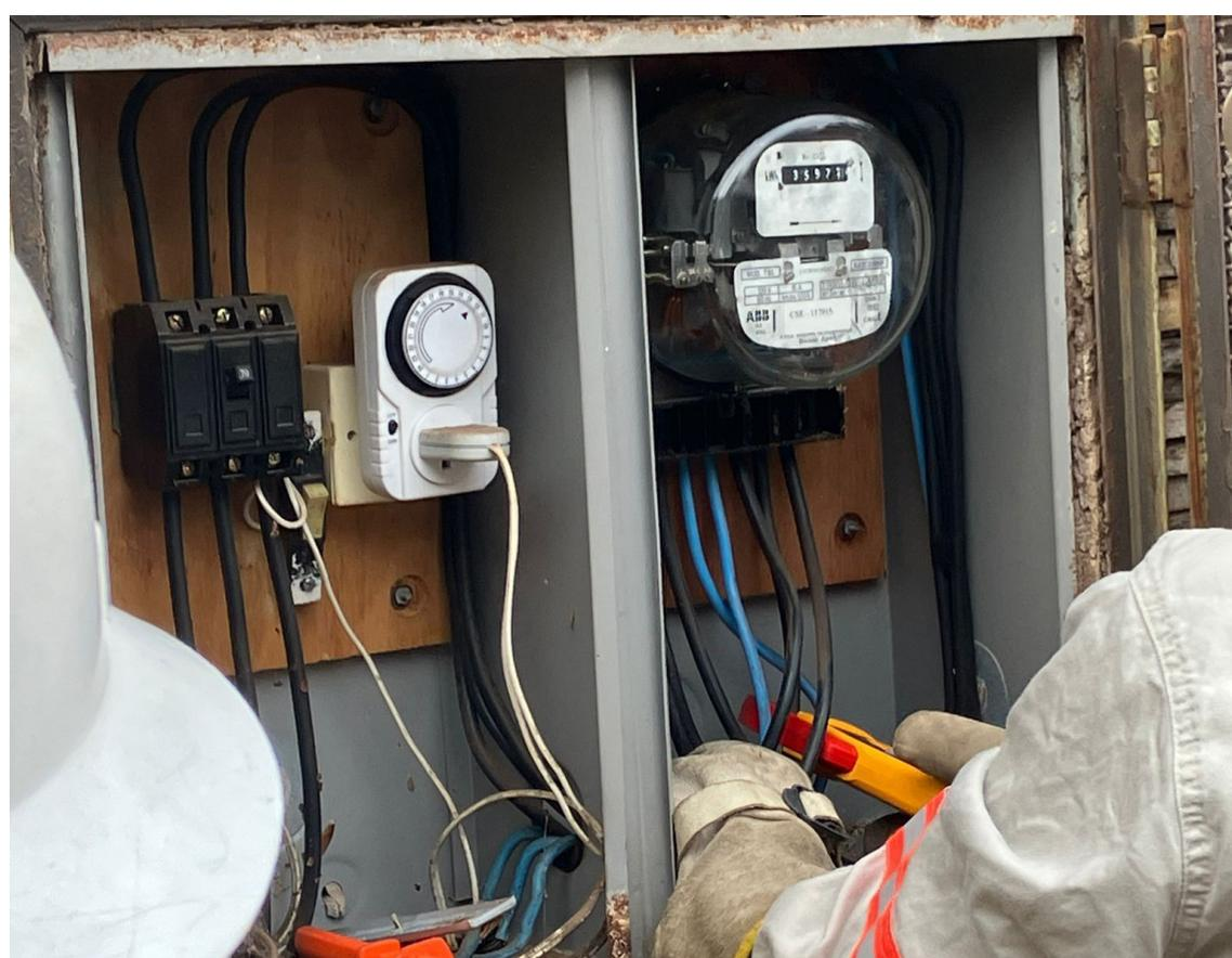
Como as ligações clandestinas são feitas sem a supervisão de profissionais qualificados, a fiação e até o aterramento são malfeitas ou inadequadas. Isso pode resultar em cabos desencapados, conexões mal isoladas ou até fios soltos, tornando o sistema mais vulnerável a falhas e aumentando o risco de acidentes.
